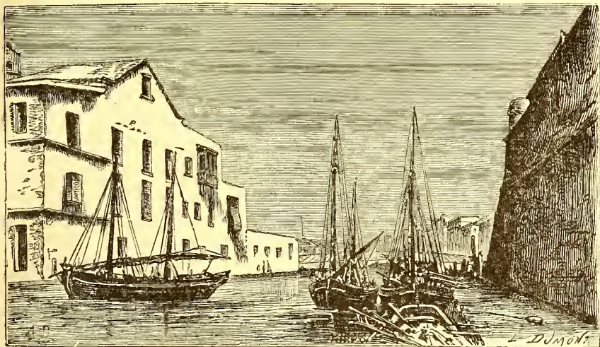
Entrée du port de la Goulette.
